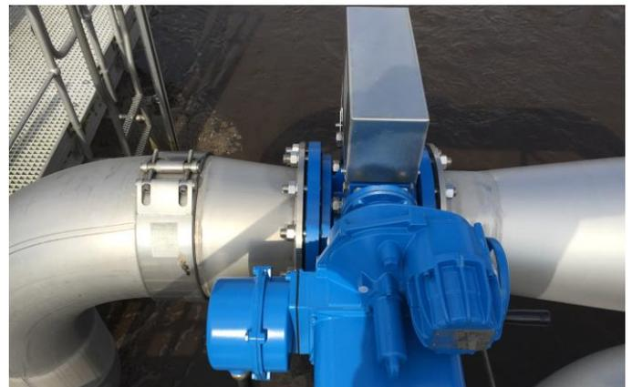
Durch die exaktere Regelung und durch die Ausnutzung des großen Regelbereichs der Iris® Blenden-Regulierschieber kann der Verdichterdruck auf ein Minimum reduziert werden. Es ergibt sich bei der eingesetzten Gleitdruckregelung eine Reduzierung des Verdichterdruckes um 35 mbar bei einem optimalen Öffnungsgrad der Iris® Blenden-Regulierschieber von 70 bis 95%. Die daraus resultierenden Energiekosteneinsparungen werden derzeit noch ermittelt.
