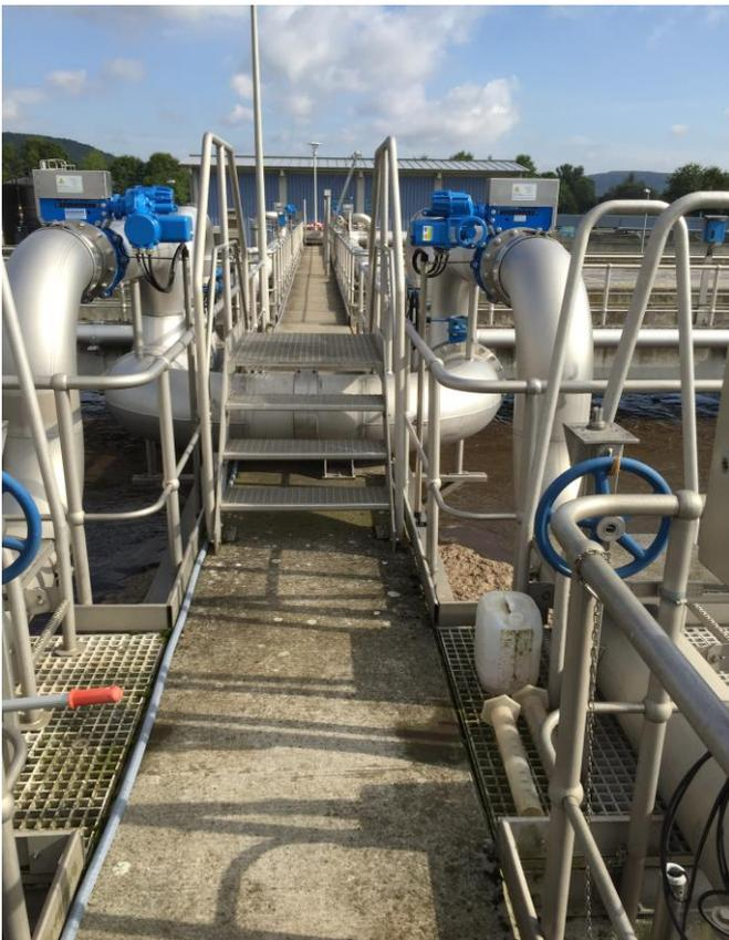
Die Belüfterelemente können zusätzlich bei einem Gebläsedruck von 625 mbar und einer Durchflussmenge von 5.520 Nm<sup>3</sup>/h interrimsmässig gespült werden.
