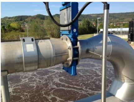
Viereck-Blenden-schieber durch Iris® Blenden-Regulierschieber ersetzt. Insgesamt werden 4 Iris® Blenden-Regulierschieber der Nennweite 200 eingesetzt. Die Anpassung an die
