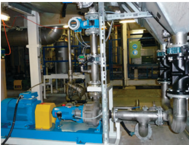
Bild 1: Filterpressenbeschickung mit einer horizontalen Egger Turo®
