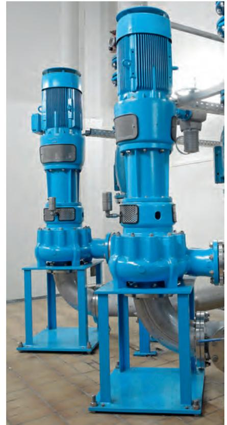
Dabei wurde besonders Wert auf die Integration in das Baukastensystem unserer Turo® Freistrom-Pumpe gelegt. Sämtliche Bauformen (getaucht, vertikale und horizontale Trockenaufstellung, als Block- oder Lagerstuhlpumpe, Schacht- und Cantileverausführungen) sind möglich.
