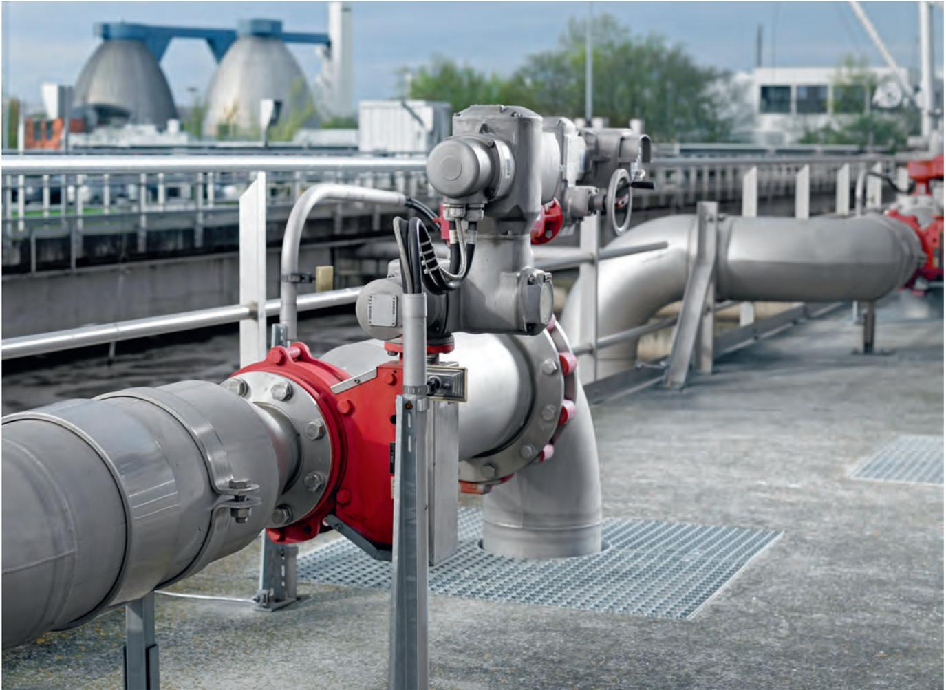
In Kläranlagen nach dem Belebtschlammverfahren werden ca. 60 % des gesamten Energiebedarfs für den Eintrag an Luftsauerstoff in die Biologie benötigt. Gerade hier besteht auf vielen Anlagen ein enorm hohes Energieeinsparpotential.
