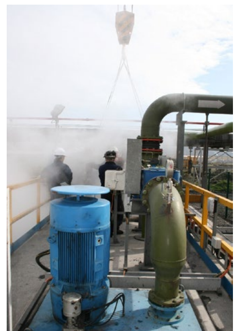
Löschwasserpumpe, EO 9-200 SR4 LB4B
