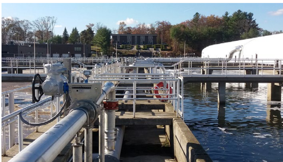
Abb 8: Iris® Blenden-Regulierschieber mit Massendurchflussmessung auf der KA Upper Blackstone
