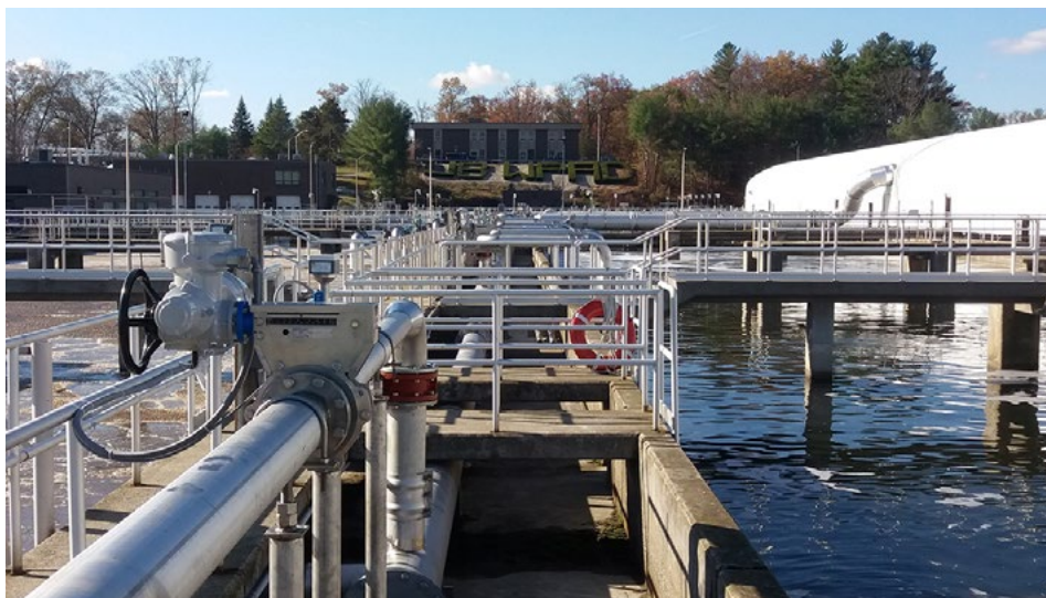
Fig. 8 : Vanne de régulation à diaphragme Iris® avec mesure du débit massique à la station d'épuration d'Upper Blackstone
