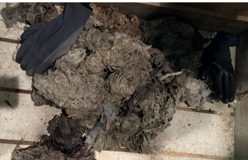
Bild 1: Zopfbildung in Kanalradpumpe
