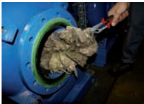
Verzapfungen vor Einbau des neuen Egger Turo® TA Laufrades.
