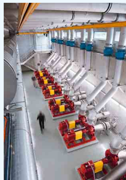
Das Kernstück des Projekts sind die beiden neuen Beschickungspumpen.
