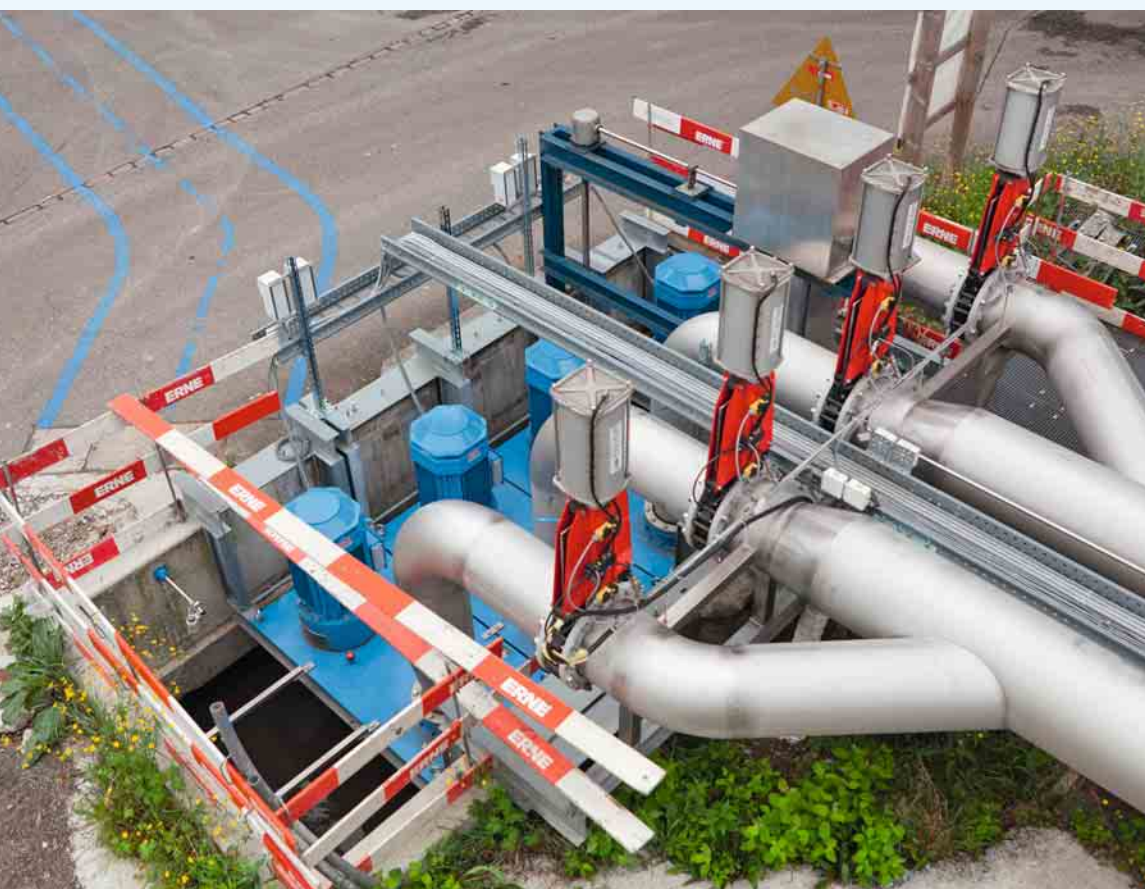
Im Zürcher Klärwerk Werdhölzli: Für die Umbauphase installierte man drei Schacht- sowie eine Reservepumpe.
