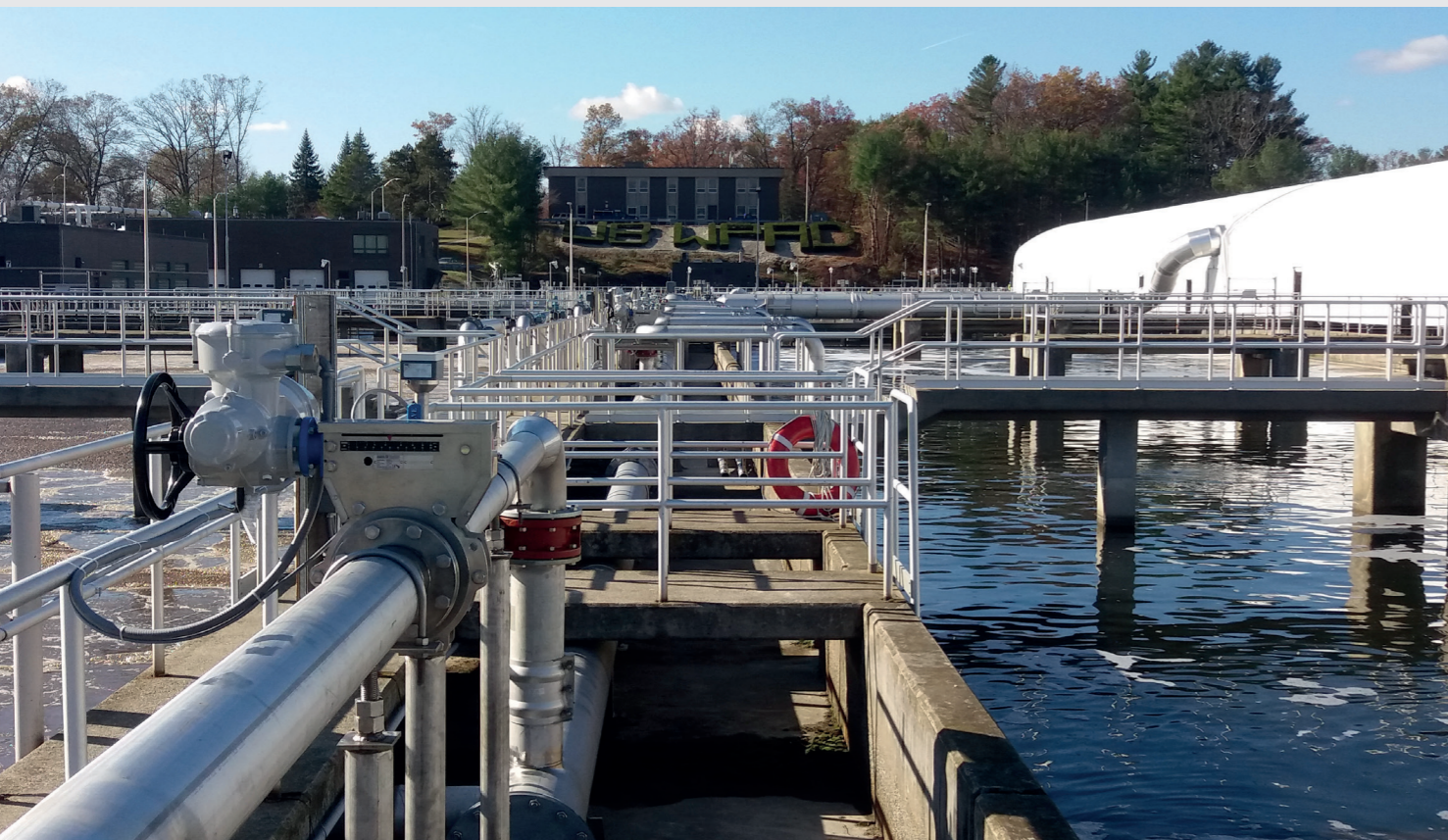
Bild 1 Kläranlage Upper Blackstone im Bundesstaat Massachusetts in den USA: Der Iris-Blenden-Regulierschieber mit Massendurchflussmessung ist hier erfolgreich im Einsatz. Quelle: Emile Egger
